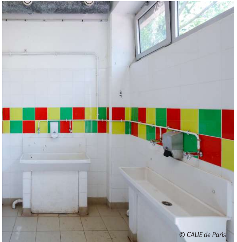
Sanitaires côté garçon : les lavabos
