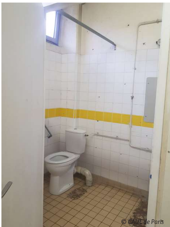
Sanitaires côté fille : les toilettes PMR
