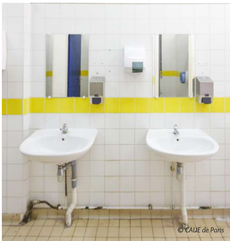
Sanitaires côté fille : les lavabos
