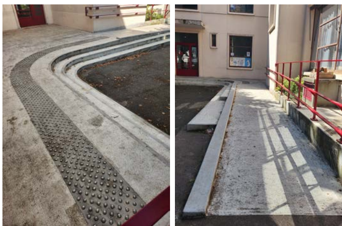
Réalisation d'une rampe et sécurisation des escaliers devant l'entrée d'une école
