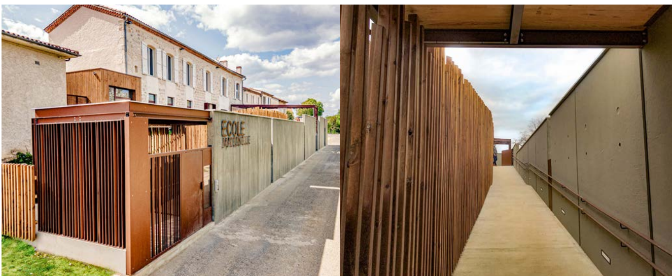
La rampe de l'école permet de répondre aux exigences d'accessibilité tout en constituant une vraie pièce d'architecture, avec un usage de sas. © Agence Airoidi architectes
